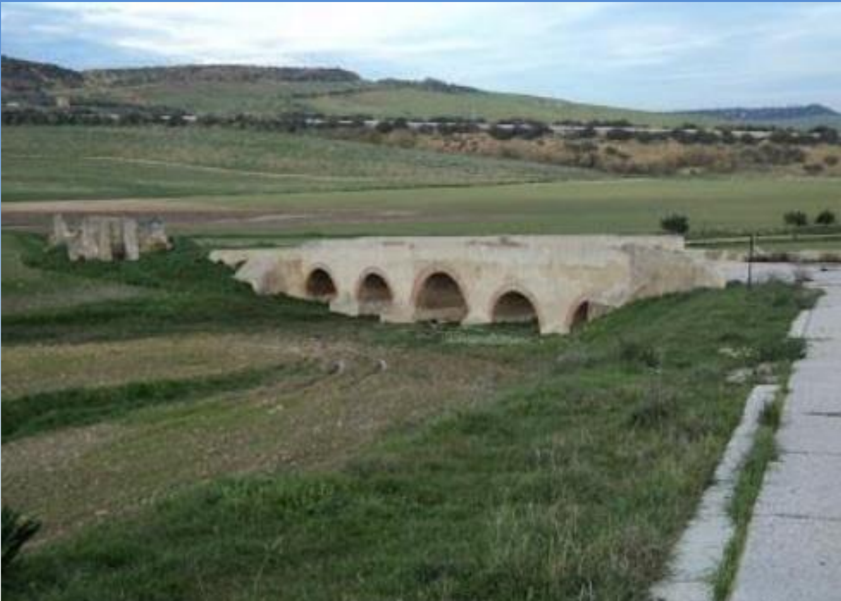
4. Antiguo puente del Arroyo Culebro. Tapado por desvío del cauce para la depuradora
