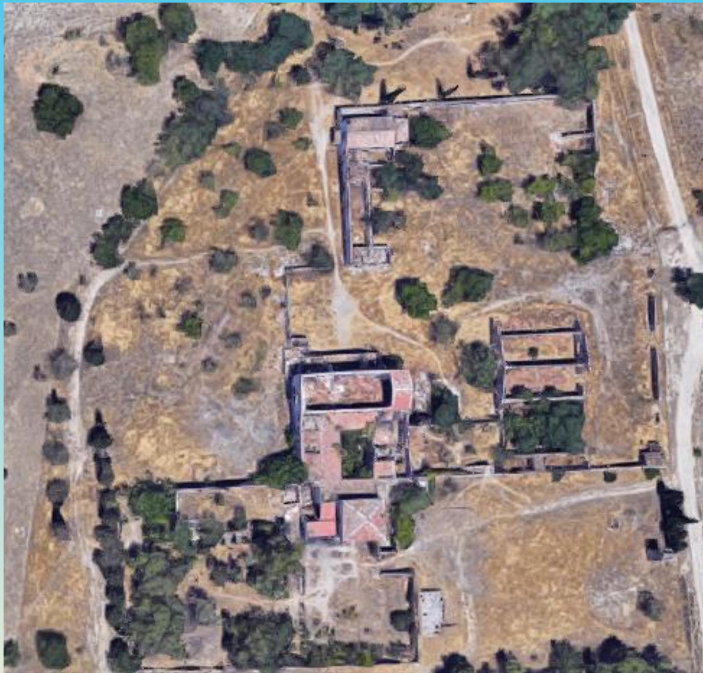
3. Convento "Val de San José" – Lamentable estado de deterioro
